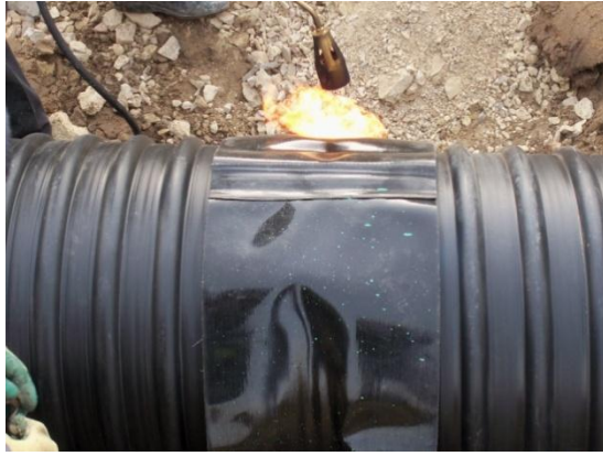
Рисунок 17. Процесс сварки газовой горелкой.
